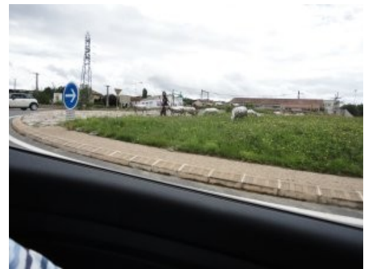
Rundkørslen ved Roquefort
