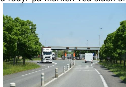
På vej ind i betalingsanlægget
