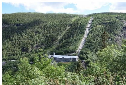
Tungtvandsanlægget ved "Juvet"
